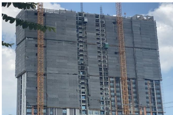
Mesh Sheet ปิดคลุมรอบตัวอาคาร (ช่วงก่อสร้าง)
