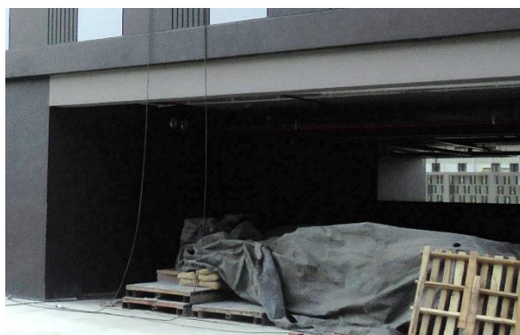
รูปที่ 2-6 การปิดคลุมวัสดุก่อสร้าง การเก็บในพื้นที่ปิดล้อม
