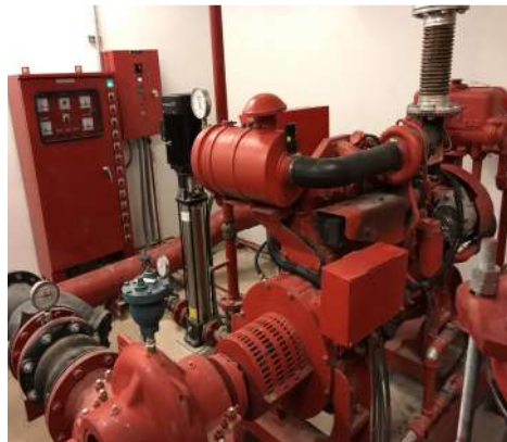
ภาพที่ 1-5 ปั้มน้ำดับเพลิง (Fire Pump)
