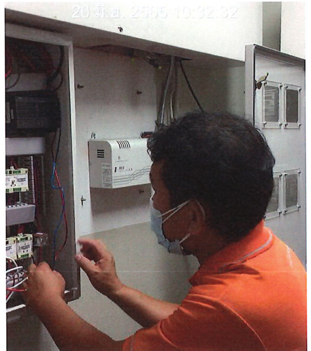
เจ้าหน้าที่จาก บริษัท สแควร์ โนว์ กรุ๊ป จำกัด เข้าแก้ไขและทดสอบระบบ Fire Alarm ภายในอาคาร ประจำปี 2565
