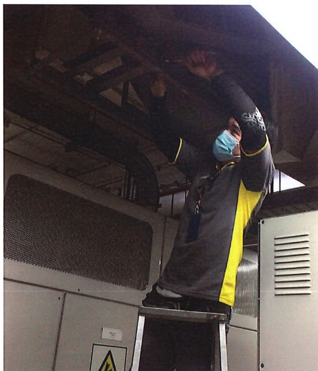
ทีมช่างอาคารดำเนินการปรับตั้งสายพาน และฉีดสเปรย์บำรุงสายพานของพัดลมดูดอากาศ บริเวณห้อง MDB
