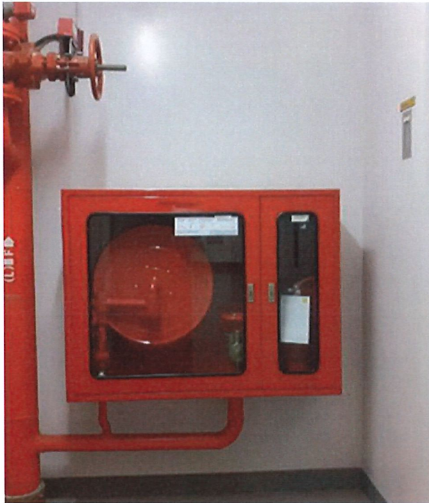
รูปที่ 19 และ 20 สายฉีดน้ำดับเพลิงและตู้เก็บสายฉีดอยู่ในสภาพพร้อมใช้งาน บ่อเก็บน้ำพร้อมใช้งานหากเกิดเหตุฉุกเฉิน
