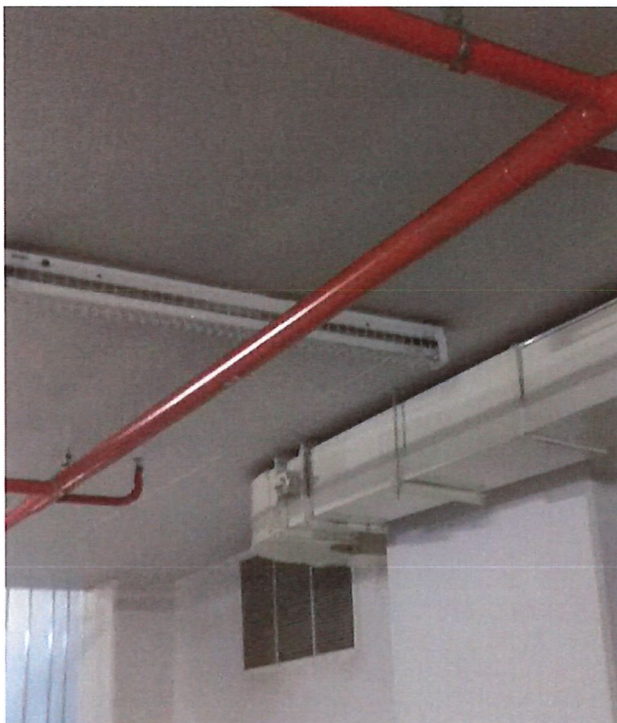
รูปที่ 21 มีระบบ Sprinkle system ภายในอาคาร
