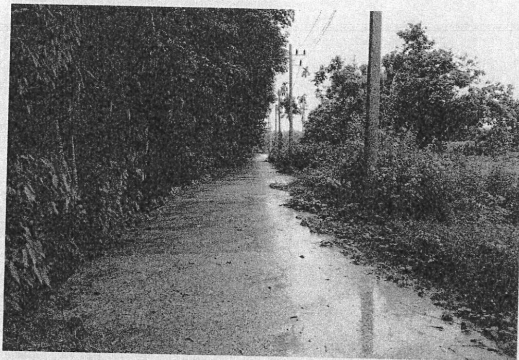
ภาพที่ 3 แสดงบริเวณทางเข้าที่มีการเทคอนกรีตป้องกันปัญหาฝุ่นและดินไปสู่ทางสายหลัก
