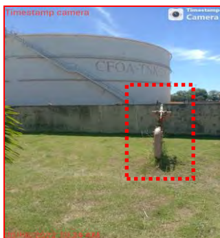
ภาพที่ 2.2-37 การติดตั้ง Monitoring Nozzle รอบ
