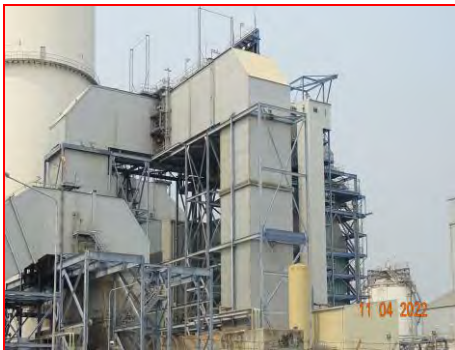
ภาพที่ 2.2-3 ระบบกำจัดก๊าซ SO 2 (Flue Gas Desulfurization: FGD)
