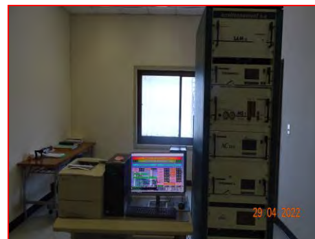
ภาพที่ 2.2-40 ห้องควบคุมระบบ CEMS
