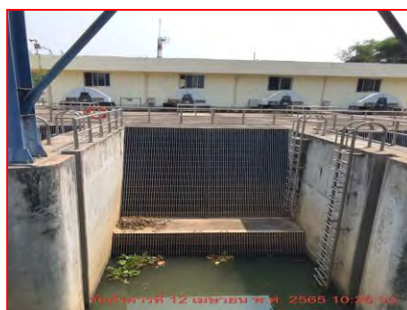
ภาพที่ 2.2-18 ตะแกรงช่องรับน้ำ บริเวณสถานีสูบน้ำท่าราบ
