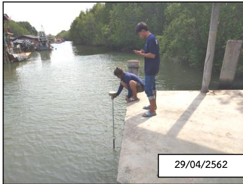
ก. การสำรวจระดับพื้นที่ท้องน้ำในแม่น้ำประแสร์ บริเวณพื้นที่โครงการ
