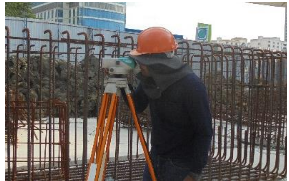
รูปที่ 2-5 การตรวจสอบควบคุมระดับพื้นดิน ตามแบบแปลนงานก่อสร้าง
