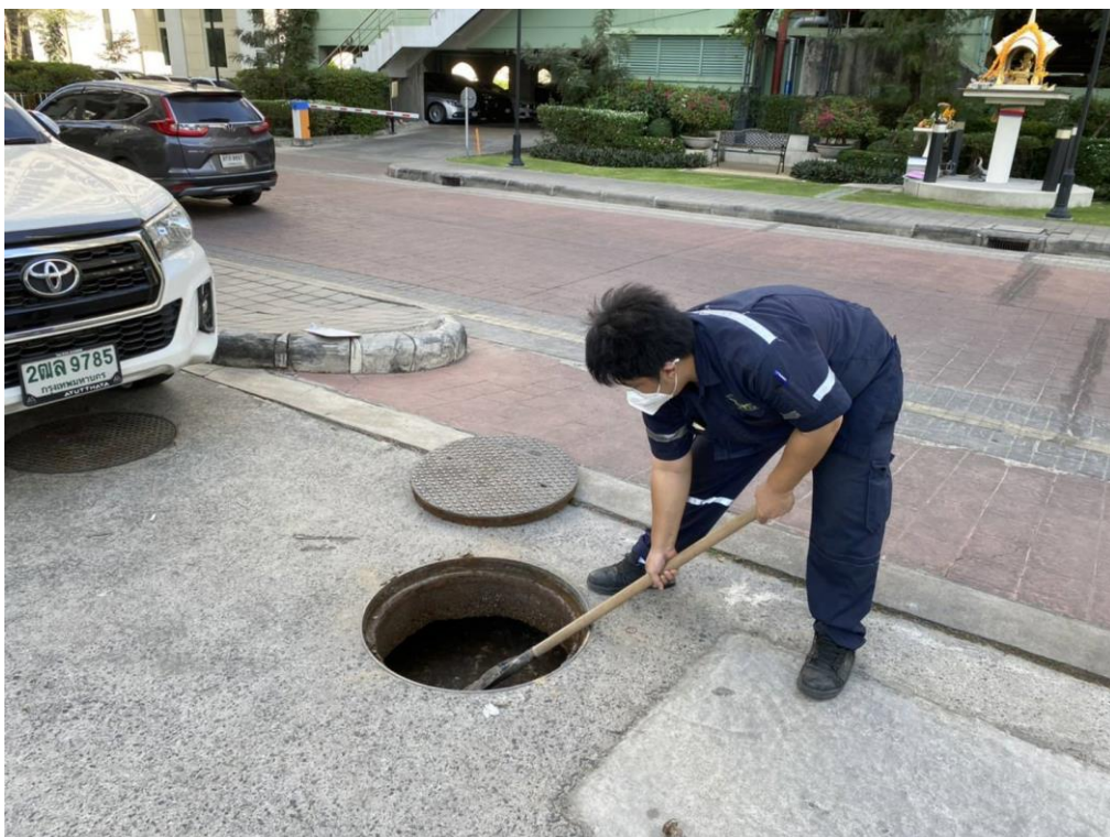
รูปที่ 13 ดำเนินการ ทำการตัดไขมันป้อนบำบัด อาคาร 1-3-5-8
