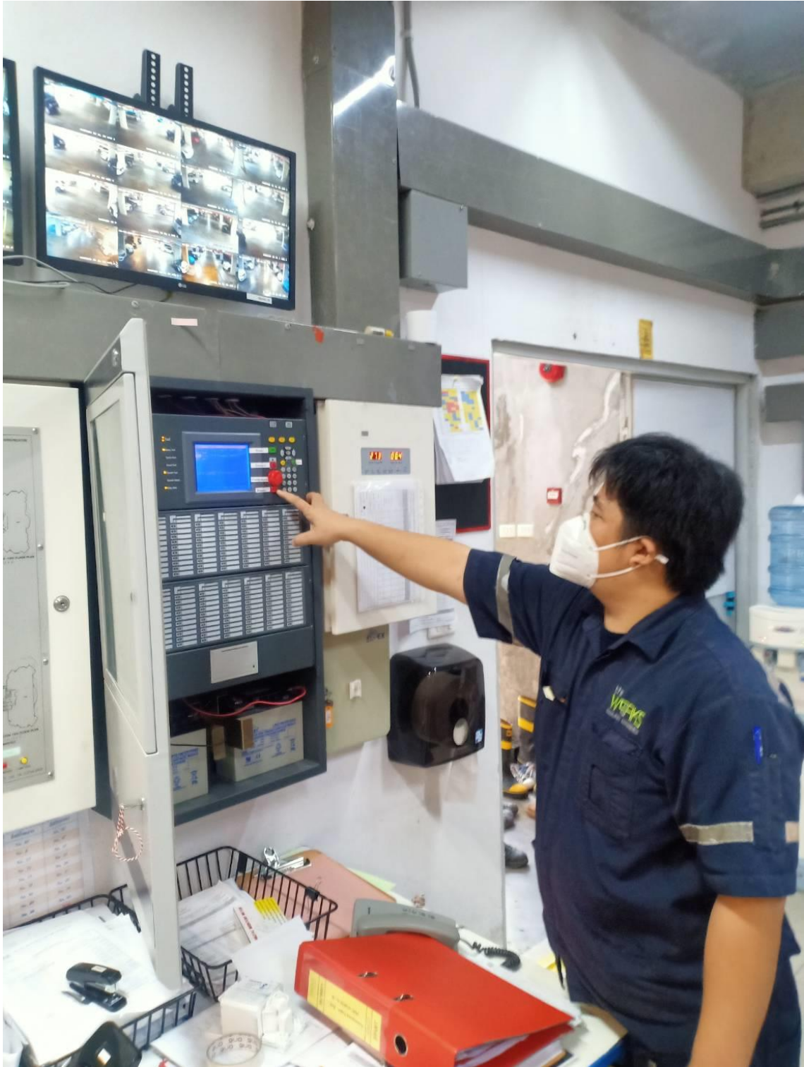
รูปที่ 45 เจ้าหน้าที่ตรวจสอบระบบสัญญาณแจ้งเหตุเพลิงไหม้
