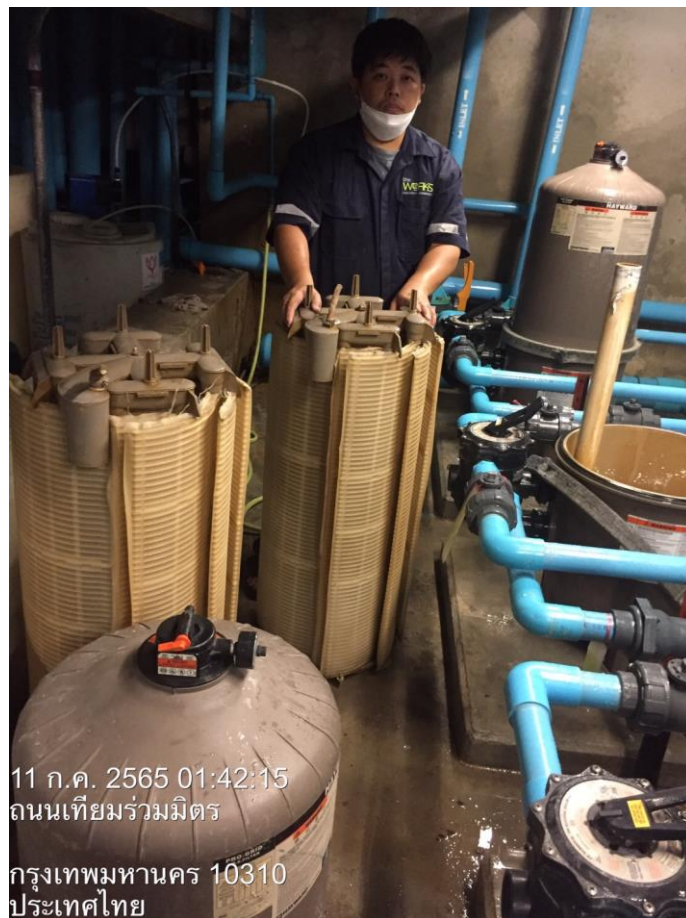
รูปที่ 38 เจ้าหน้าที่ทำความสะอาดเครื่องกรองน้ำสระเวย์น้ำ
