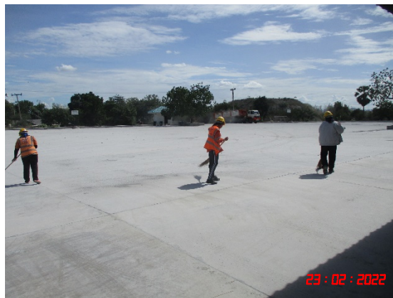
รูปที่ 2-17 การเก็บกวาดฝุ่นละอองที่ตกบนผิวถนนลาดยาง
