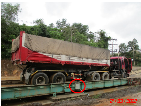
รูปที่ 2-8 ระบบสเปรย์น้ำล้างล้อ
