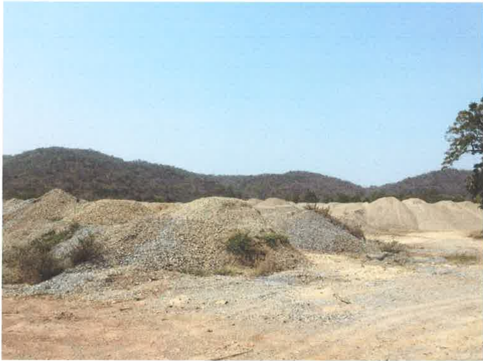
ภาพที่ ๔ : การนำเปลือกดินและเศษหินในบริเวณพื้นที่โครงการมาไม่เป็นหินคลุกเพื่อการก่อสร้าง
