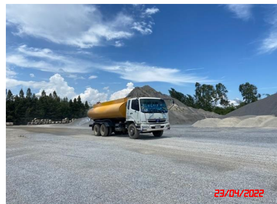
รูปที่ 2-9 การฉีดพรมน้ำในพื้นที่โครงการ
