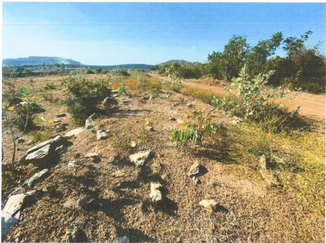
ภาพที่ 6 : สภาพคันดินที่เสียหายจากการบุกรุกของสัตว์และต้นไม้ที่ปลูกบนคันดิน หมวดหลักฐานที่ 11-1 เมื่อปี 2564
