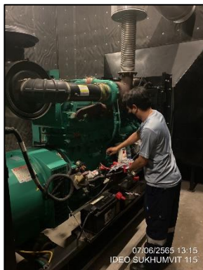
ภาพที่ 26 เครื่องกำเนิดไฟฟ้าสำรอง
