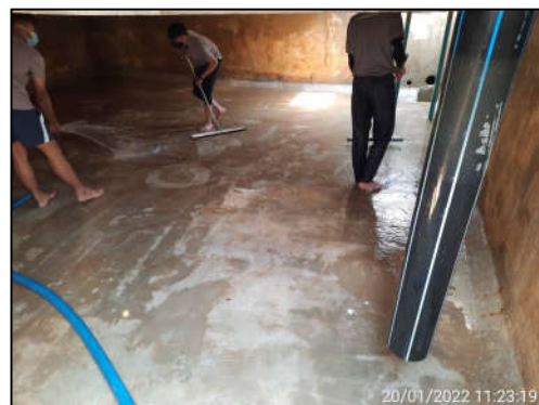
รูปที่ 3-18 การตรวจสอบและทำความสะอาดถังสำรองน้ำใช้
