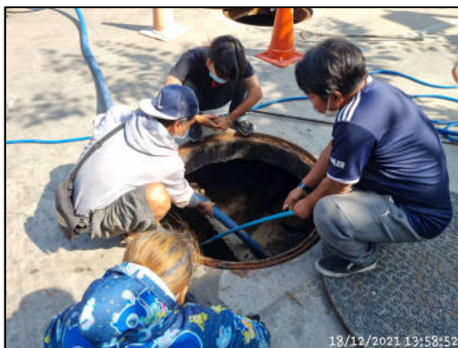
รูปที่ 2-36 การสูบน้ำในบ่อเกรอะ
