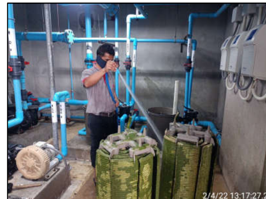
รูปที่ 2-46 การทำความสะอาดเครื่องกรองน้ำของสระว่ายน้ำ
