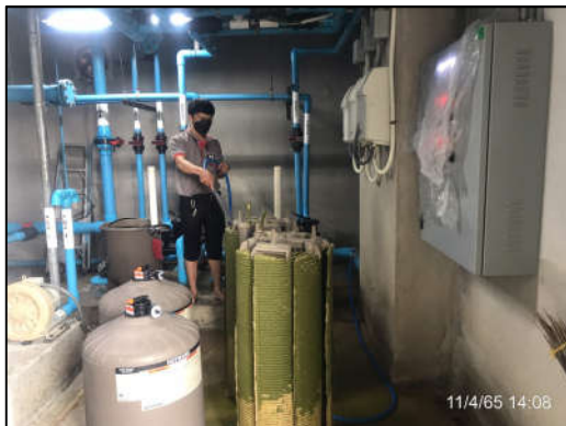
รูปที่ 2-46 การทำความสะอาดเครื่องกรองน้ำของสระว่ายน้ำ
