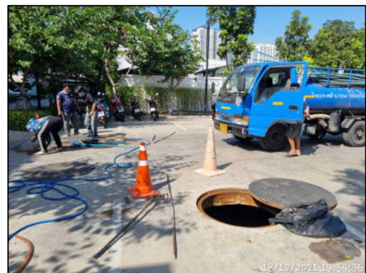
รูปที่ 2-36 การสูบน้ำในบ่อเกรอะ
