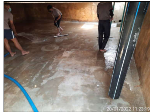
รูปที่ 2-30 การทำความสะอาดถึงเก็บน้ำสำรอง
