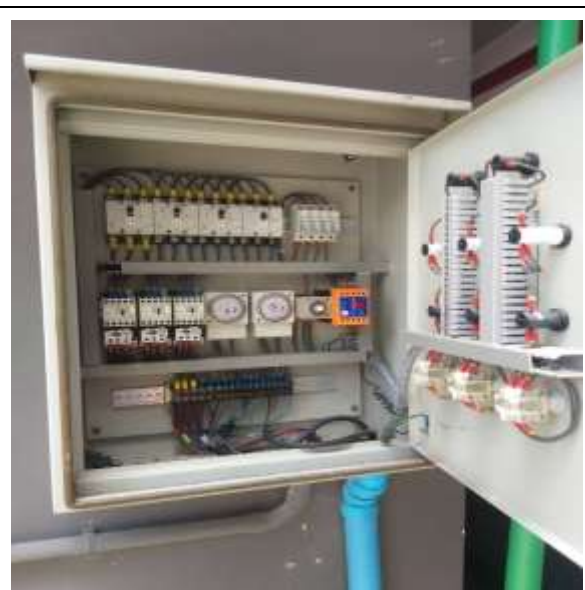
รูปที่ 2.4.2-3 ตู้ควบคุมระบบบำบัดน้ำเสีย
