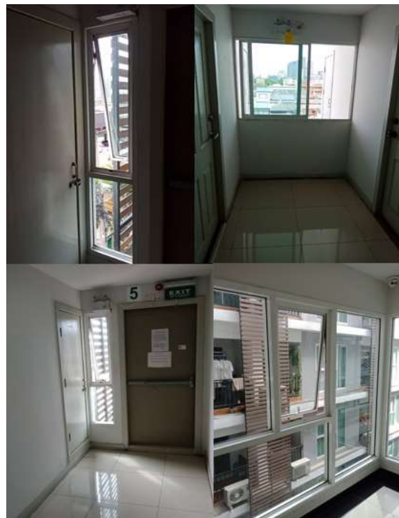
ภาคผนวกที่ 3.26 ตรวจสอบช่องระบาย อากาศธรรมชาติ
