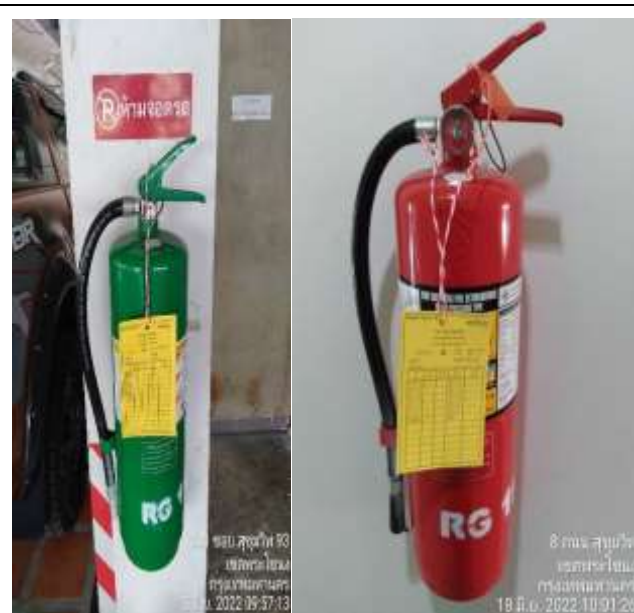
รูปที่ 2.4.6-3 ดับเพลิงมือถือ ชนิด ABC ขนาด 10 ปอนด์
