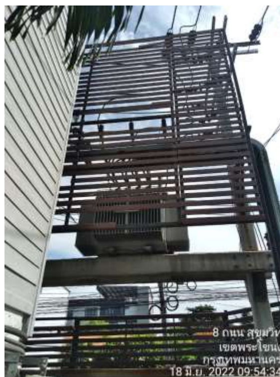
รูปที่ 2.4.5-2 หม้อแปลงไฟฟ้า ชุดที่ B
