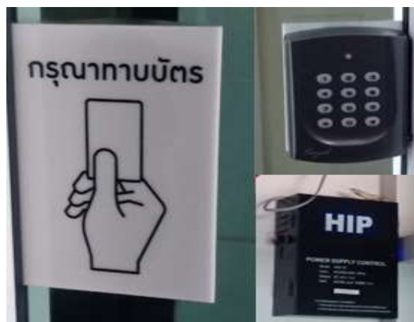
รูปที่ 2.4.11-2 ระบบควบคุมประตูอัตโนมัติ
