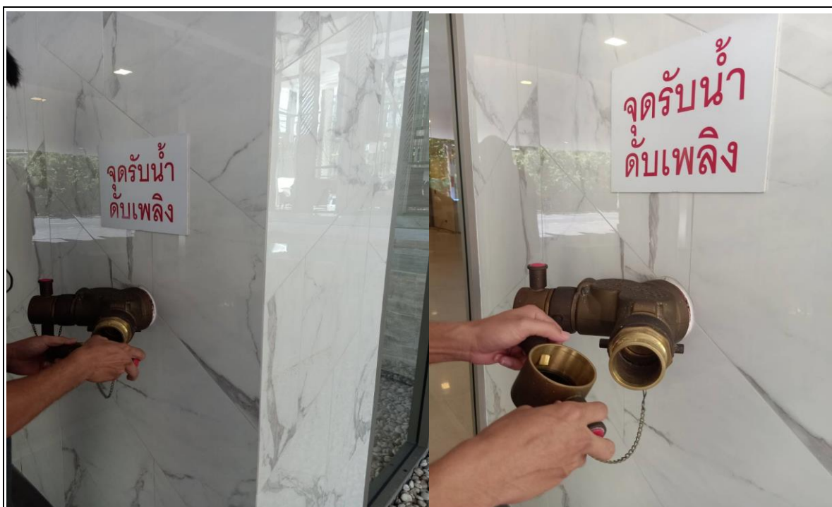
ภาคผนวกที่ 3-26 ตรวจสอบหัวรับน้ำดับเพลิง
