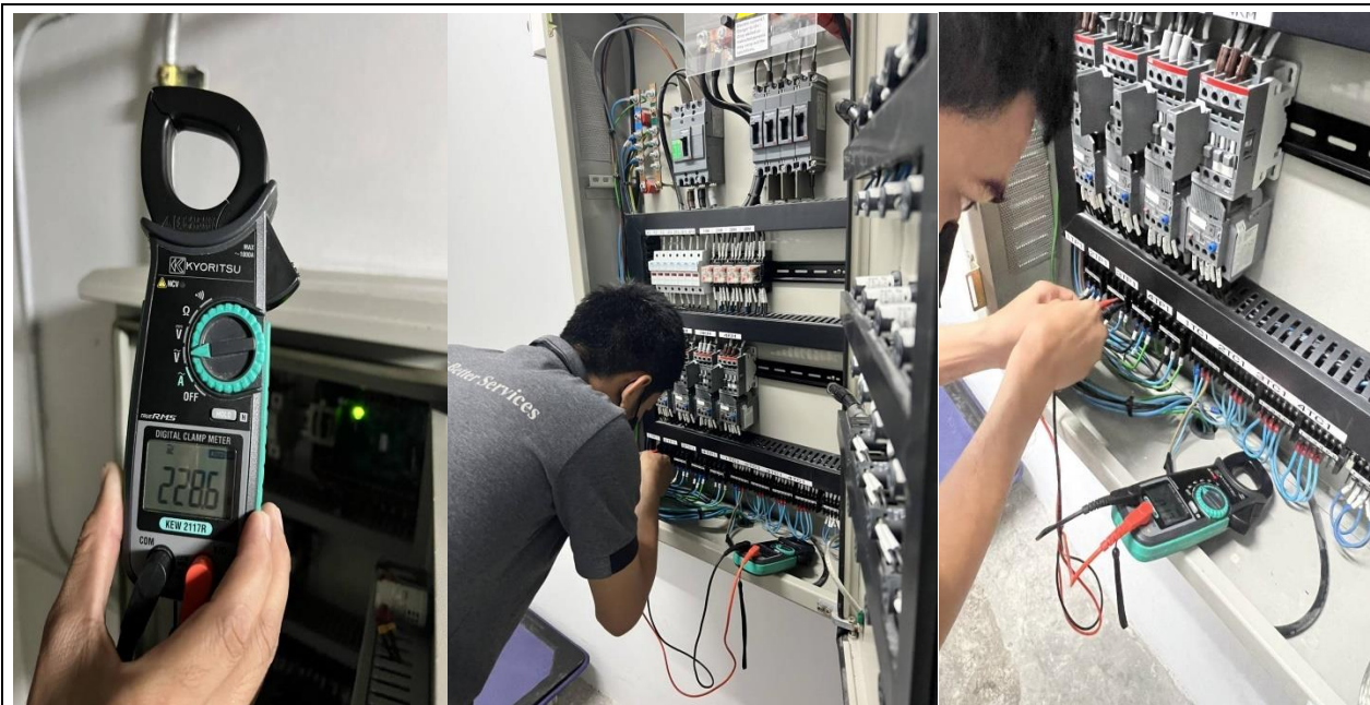
ภาคผนวกที่ 3-19 การตรวจสอบระบบ Pump ภายในโครงการ
