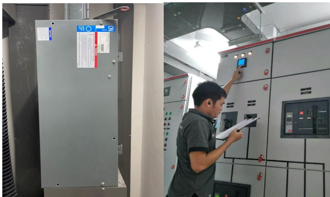
ภาคผนวกที่ 3-34 ตำแหน่งสะพานไฟ สำหรับตัดกระแสไฟฟ้า
