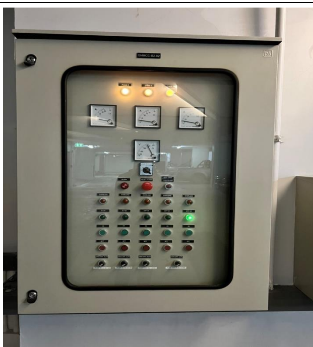
รูปที่ 2.4.3-2 ตู้ควบคุมระบบบำบัดน้ำเสีย
