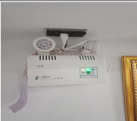
รูปที่ 2.4.8-9 ไฟส่องสว่างฉุกเฉิน
