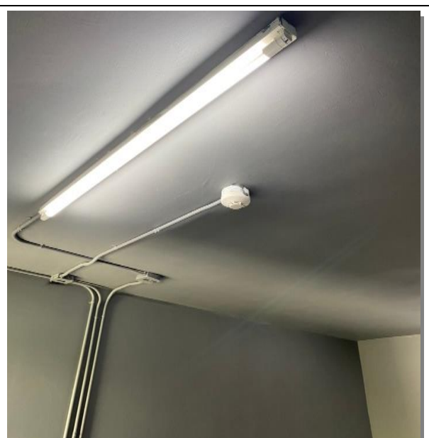
รูปที่ 2.4.8-2 อุปกรณ์ตรวจจับควันและความร้อน
