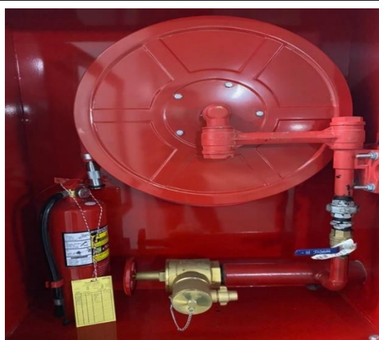
รูปที่ 2.4.8-4 ตู้เก็บสายน้ำดับเพลิงพร้อมอุปกรณ์
