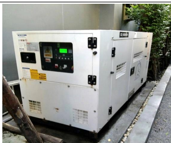
รูปที่ 2.4.6-2 เครื่องกำเนิดไฟฟ้าสำรอง
