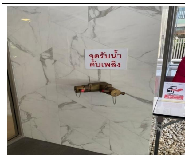
รูปที่ 2.4.8-3 หัวรับน้ำดับเพลิงภายนอกอาคาร
