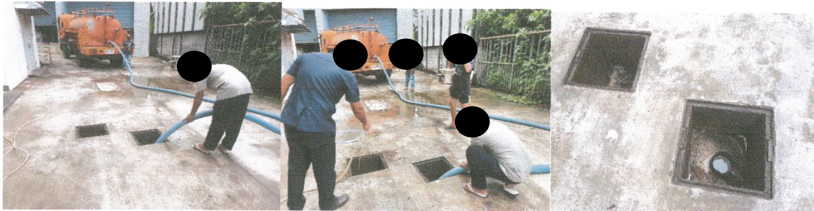
ภาพที่ 2-5 ภาพการสูบน้ำออกจากบ่อดักไขมัน
