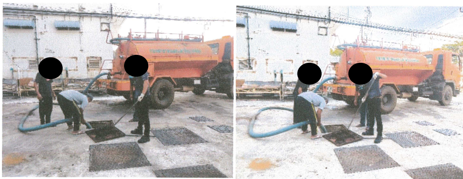
ภาพที่ 2-6 ภาพแสดงการสูบน้ำจากถังเกรอะ
