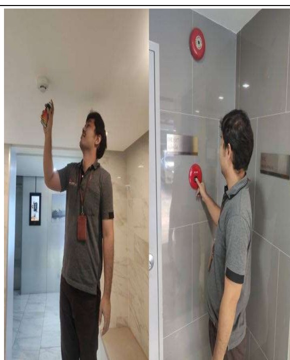
ภาคผนวกที่ 3.16 การตรวจสอบระบบเตือนอัคคีภัย
