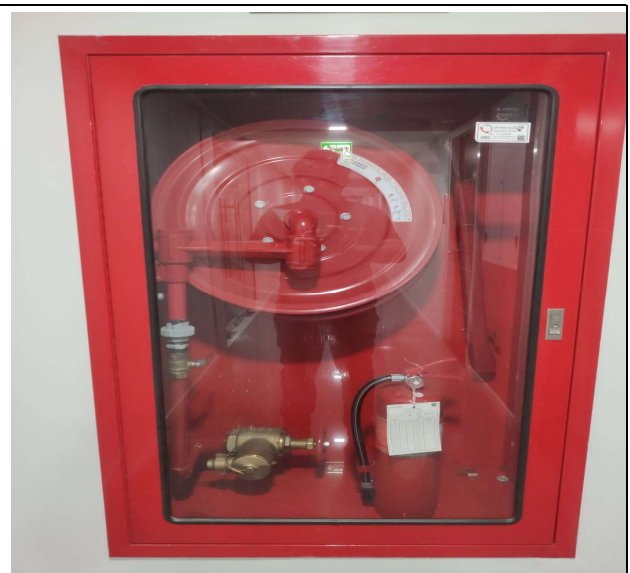
รูปที่ 2.4.6.1-2 ตู้เก็บสายน้ำดับเพลิงพร้อมอุปกรณ์
