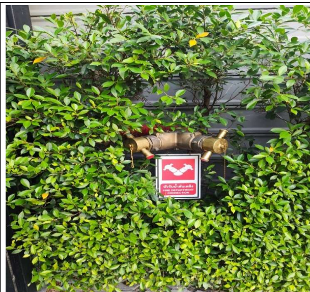
รูปที่ 2.4.6.1-1 หัวรับน้ำดับเพลิงภายนอกอาคาร
