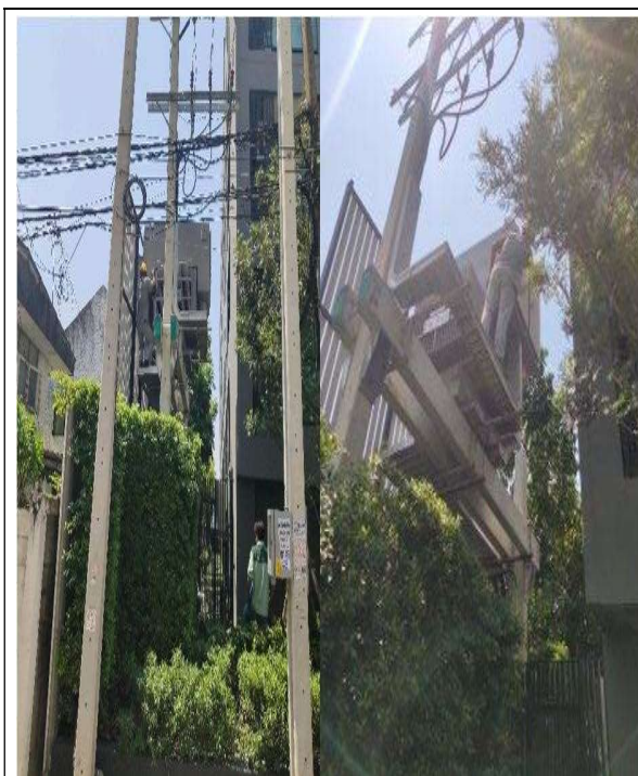
ภาคผนวกที่ 3.33 การซ่อมบำรุงหม้อแปลงไฟฟ้า
