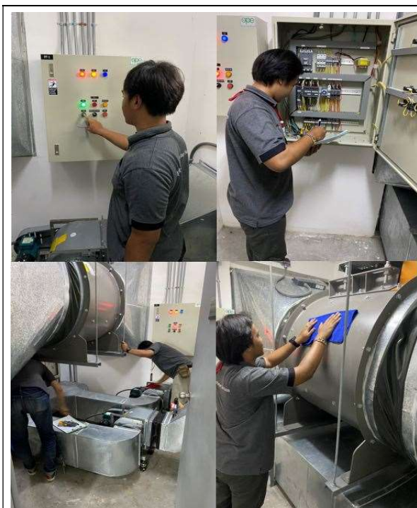
ภาคผนวกที่ 3.37 การตรวจสอบการทำงานพักลมอัด อากาศบนไดโหนดไฟ
