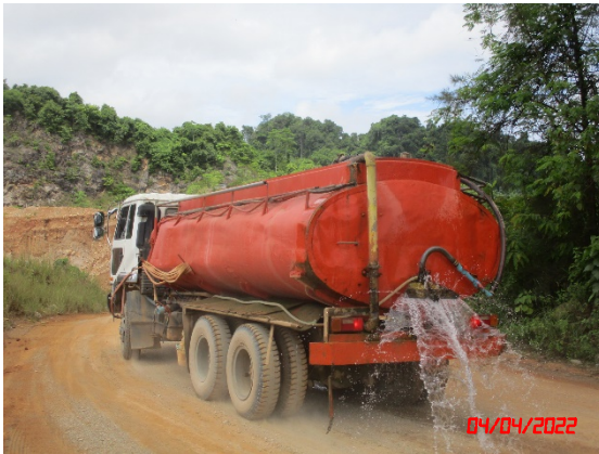
รูปที่ 2-7 การฉีดพรมน้ำบริเวณเส้นทางขนส่งแร่
