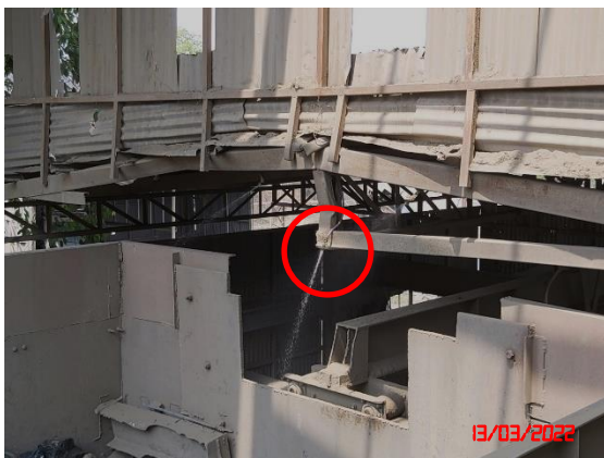
ระบบสเปรย์น้ำบริเวณกำเนิดฝุ่นละออง
