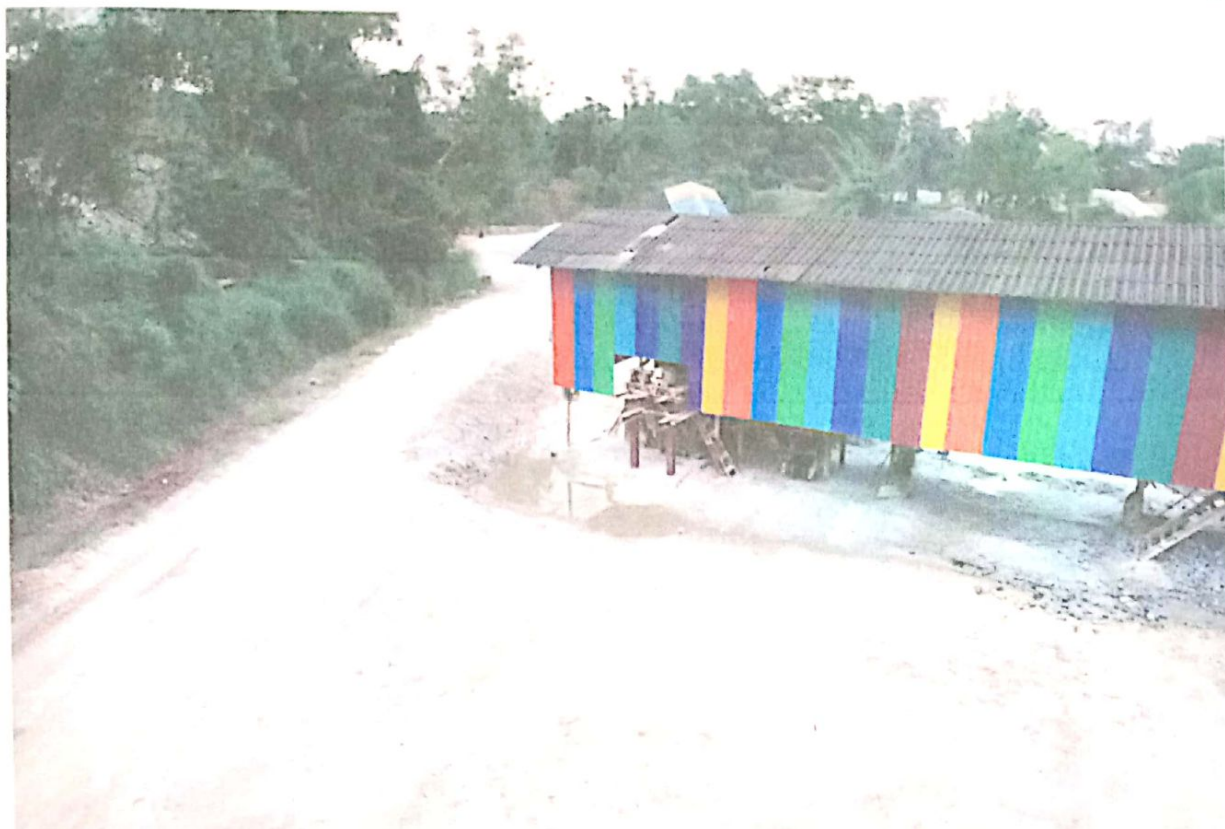
ภาพที่ 5 พื้นที่โรงแต่งแร่ ที่บริเวณโดยรอบผ่านการปลูกต้นไม้ซึ่งปัจจุบันเกือบเต็มพื้นที่แล้วและการติด metal sheet เป็นแนวป้องกันฝุ่นออกนอกบริเวณ
