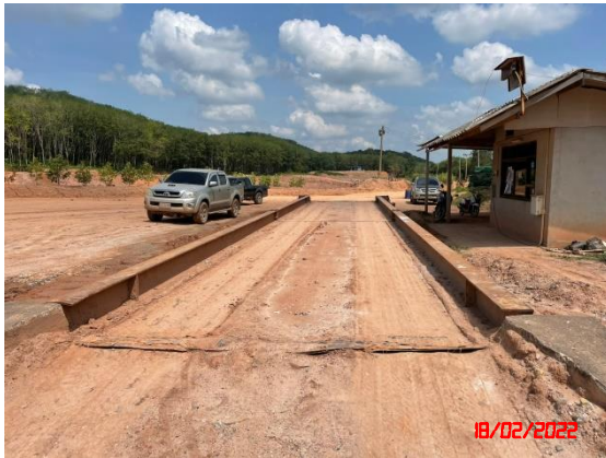
รูปที่ 2-22 จุดขนถ่ายน้ำหนักรถบรรทุก
