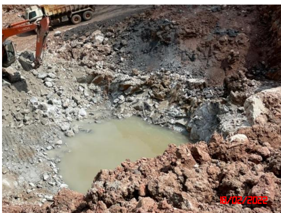
รูปที่ 2-27 บ่อรับน้ำ (Sump)
