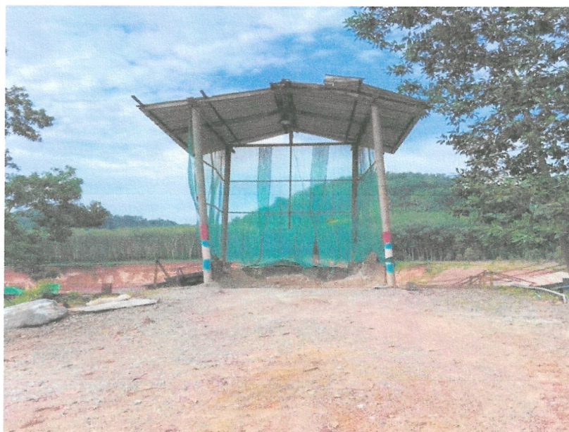
โรงแต่งแร่ปิดคลุมมิดชิด/พื้นลานกองแร่บดอัดแน่น
