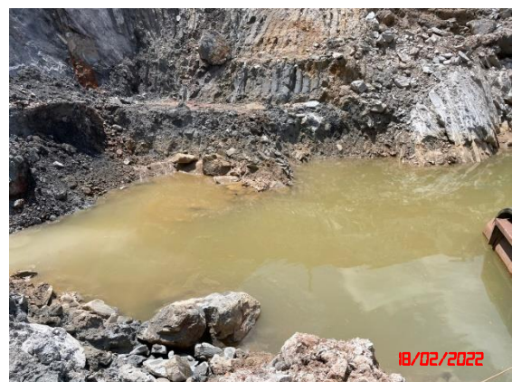
รูปที่ 2-27 บ่อรับน้ำ (Sump)
