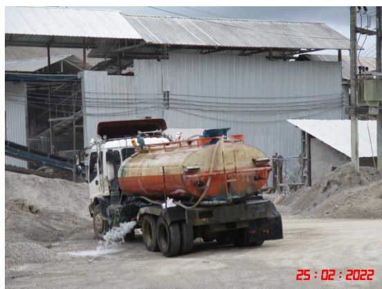
รูปที่ 2-6 การฉีดพรมน้ำบริเวณพื้นที่โครงการ
