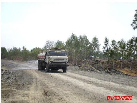
รูปที่ 2-17 การฉีดพรมน้ำเพื่อลดการฟุ้งกระจายของฝุ่นละออง
