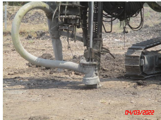
รูปที่ 2-17 การฉีดพรมน้ำเพื่อลดการฟุ้งกระจายของฝุ่นละออง
