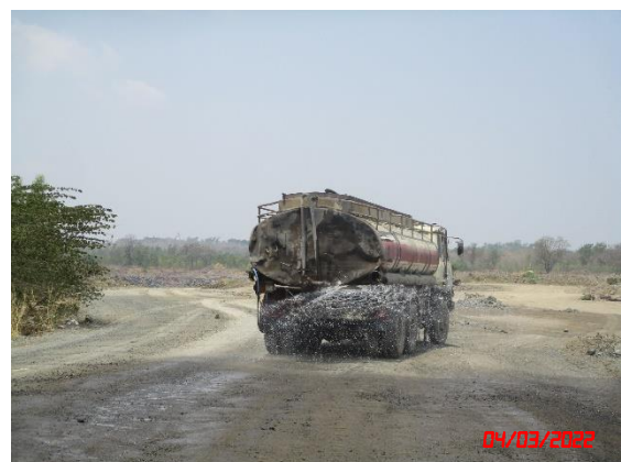
รูปที่ 2-17 การฉีดพรมน้ำเพื่อลดการฟุ้งกระจายของฝุ่นละออง
