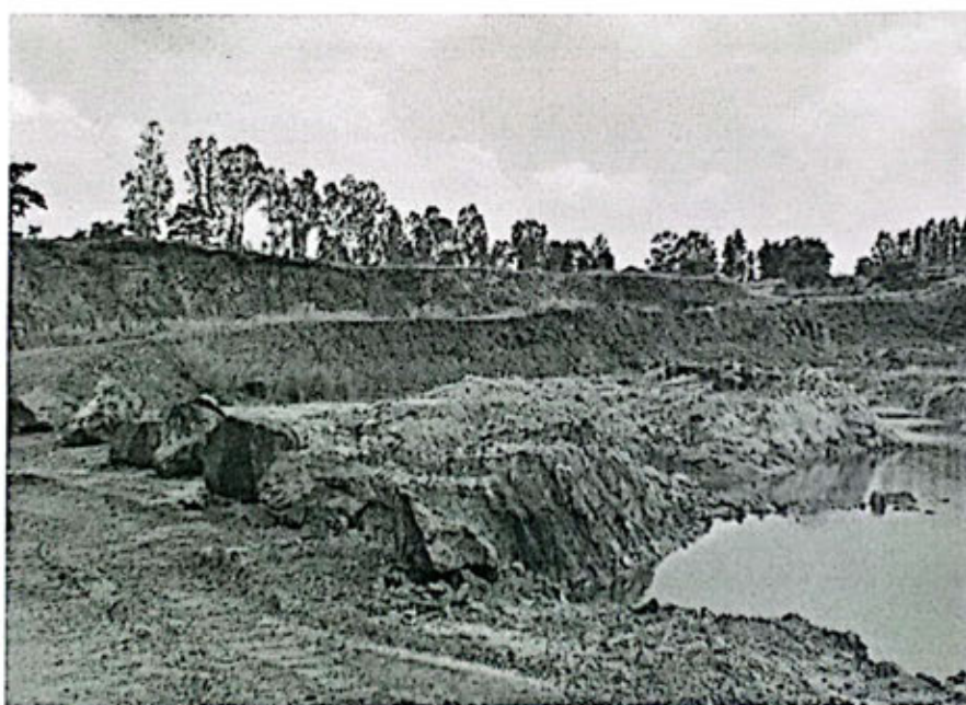
รูปที่ 4 ปรับความลาดชันของหน้าเหมืองพร้อมปดุดันไม้รอบบ่อเหมือง
