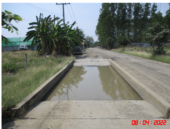
รูปที่ 2-8 ลานล้างล้อก่อนออกสู่ทางหลวงหมายเลข บร.3001
