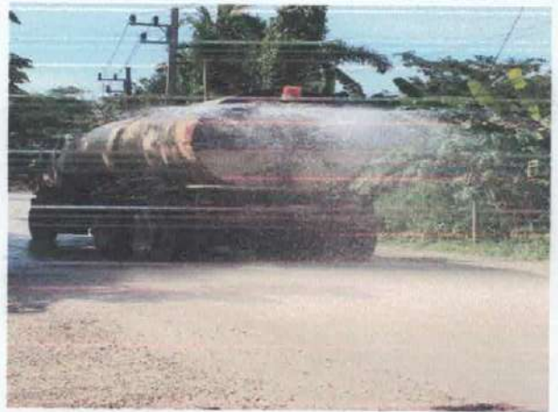
รูปที่ 2 ใช้รถบรรทุกน้ำฉีดพรมบริเวณเส้นทาง ถ้าเลียงแร่
