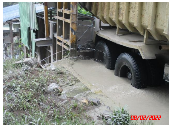
รูปที่ 2-11 ลานล้างล้อและระบบสเปรย์น้ำบริเวณพื้นที่โครงการ
