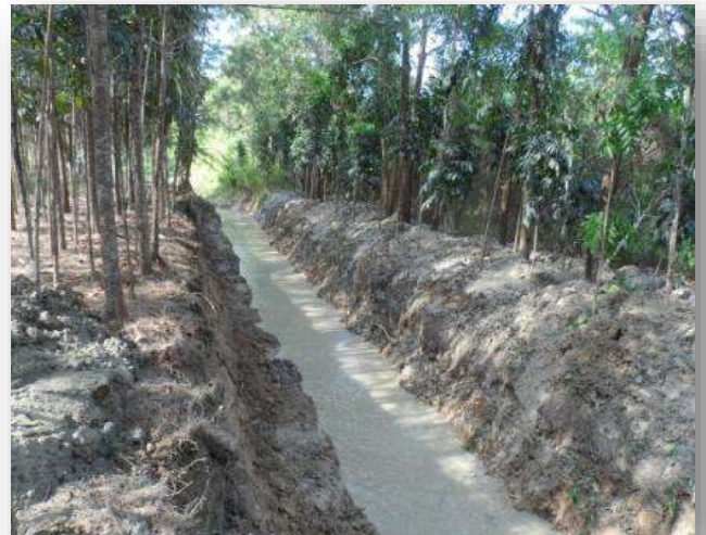
ภาพที่ 11 ภาพหลังการขุดลอกบ่อดักตะกอน
