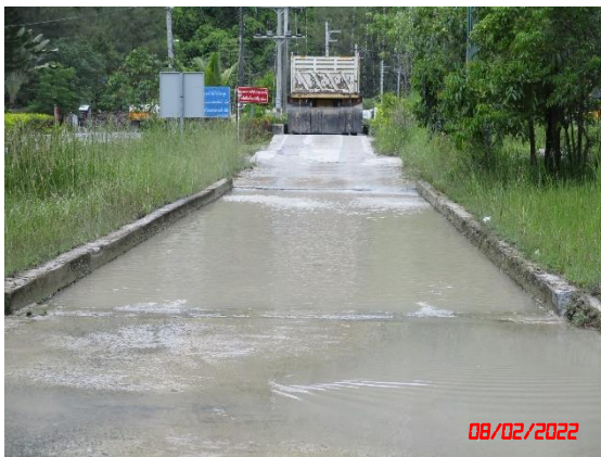
รูปที่ 2-11 ลานล้างล้อและระบบสเปรย์น้ำบริเวณพื้นที่โครงการ
