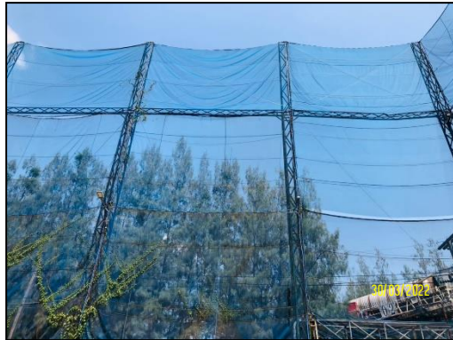
รูปที่ 2-19 แนวตาข่ายกันฝุ่นล้อมรอบลานกองเชื้อเพลิง ลานใน ทิศตะวันออก
