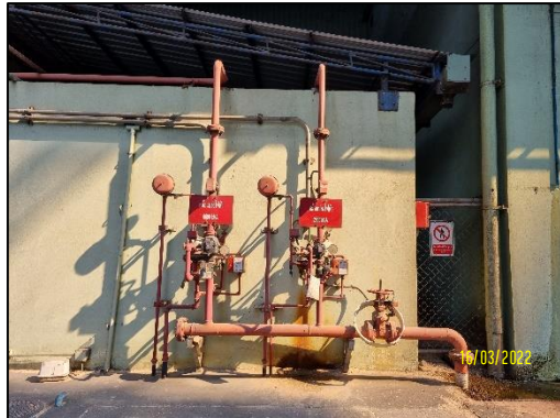
รูปที่ 2-61 วาล์วจ่ายน้ำดับเพลิงบริเวณพื้นที่หม้อแปลงไฟฟ้า
