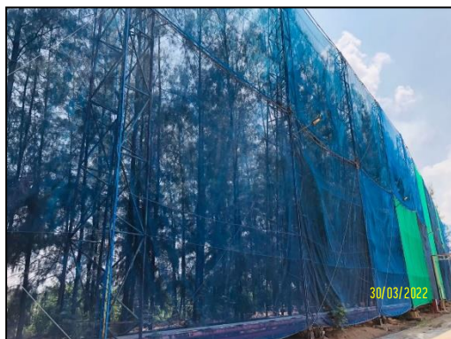
รูปที่ 2-23 แนวตาข่ายกันฝุ่นล้อมรอบลานกองเชื้อเพลิง ลานนอก ทิศใต้
