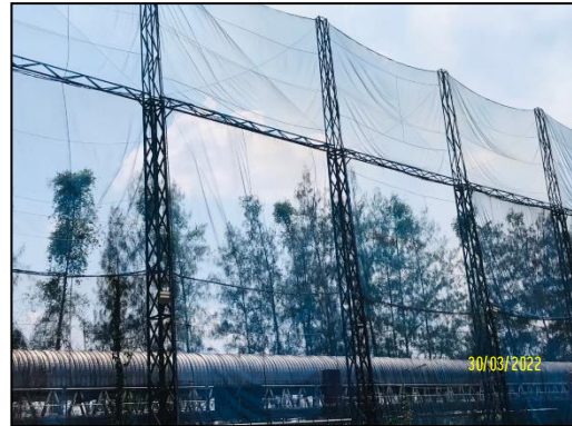
รูปที่ 2-20 แนวตาข่ายกันฝุ่นล้อมรอบลานกองเชื้อเพลิง ลานใน ทิศใต้
