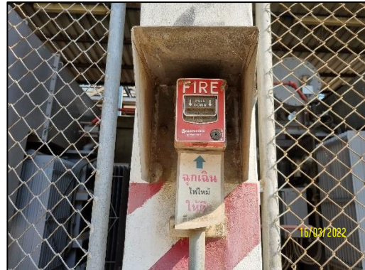
รูปที่ 2-62 อุปกรณ์แจ้งเหตุเพลิงไหม้ บริเวณพื้นที่หม้อแปลงไฟฟ้า
