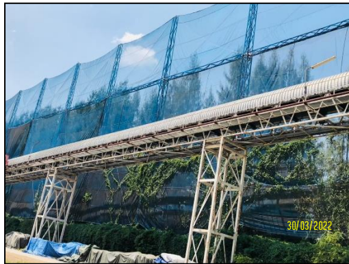
รูปที่ 2-21 แนวตาข่ายกันฝุ่นล้อมรอบลานกองเชื้อเพลิง ลานใน ทิศเหนือ
