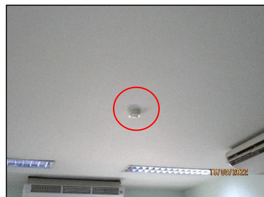
รูปที่ 2-66 อุปกรณ์ตรวจจับความร้อน บริเวณอาคารสำนักงาน
