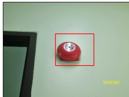
รูปที่ 2-64 สัญญาณเตือนภัยบริเวณอาคารสำนักงาน
