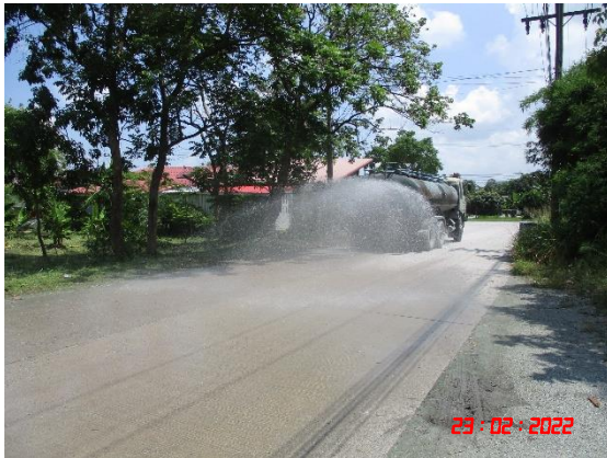
รูปที่ 2-10 การฉีดพรมน้ำเพื่อลดการฟุ้งกระจายของฝุ่นละออง
