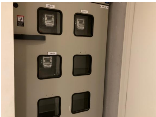
รูปที่ 2-28 มิเตอร์ไฟฟ้าแต่ละชั้น
