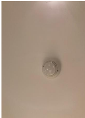
รูปที่ 2-8 เครื่องดักจับควัน
