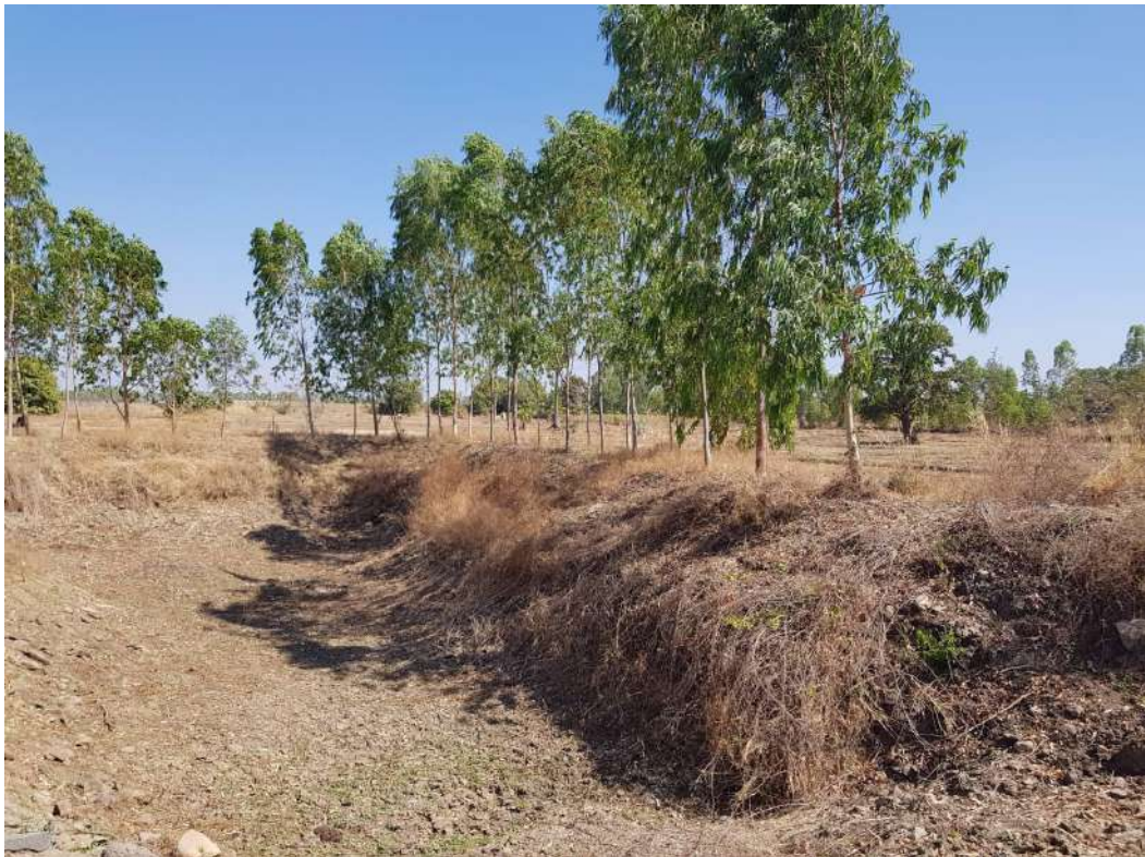
รูปที่ 5 แนวคันดินทำนบ คูระบายน้ำ บ่อตกตะกอน และ ต้นไม้โตเร็วบนคันดิน
