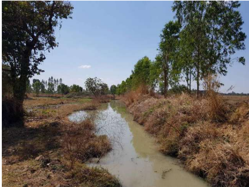
รูปที่ 6 เสริมคันทำนบดิน และขุดคูระบายน้ำและป่อดักตะกอน แนวหมุด 21-22 และเตรียมปลูกไม้โตเร็วบนคันดินต้นฤดูฝนที่จะถึง
