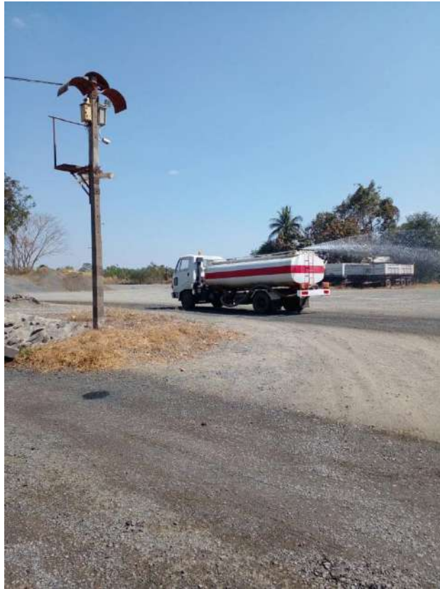
รูปที่ 9 ใช้รถน้ำช่วยลดผลกระทบบริเวณที่เกิดฝุ่น
