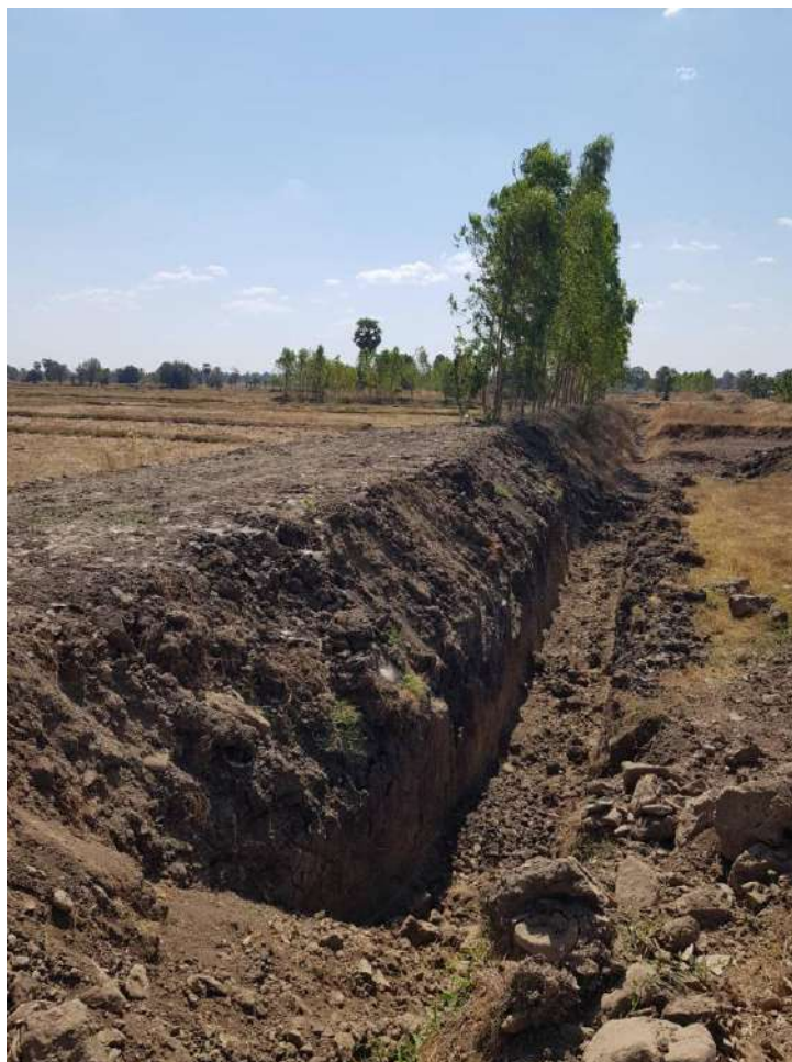
รูปที่ 6 เสริมคันทำนบดิน และขุดคูระบายน้ำและป่อดักตะกอน แนวหมุด 21-22 และเตรียมปลูกไม้โตเร็วบนคันดินต้นฤดูฝนที่จะถึง
