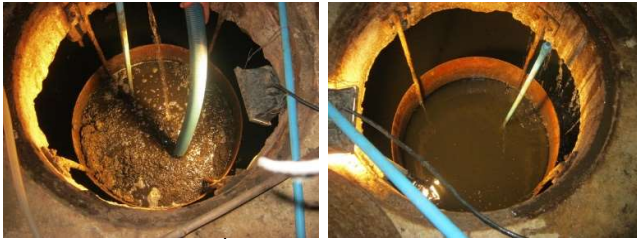
ภาพที่ 3-B ป่อสูบลบตะกอนกลับ
