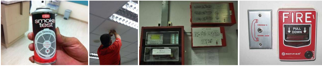
รูปที่ 28 การตรวจสอบสภาพความพร้อมใช้ของระบบสัญญาณแจ้งเหตุเพลิงไหม้
