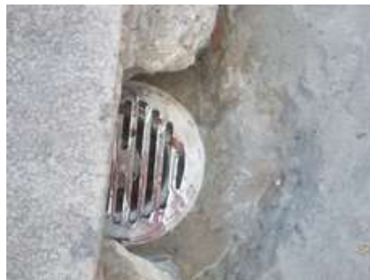
ภาพที่ 6-H สภาพท่อระบายน้ำรอบห้องพักขยะ ซึ่งน่าที่เกิตขึ้นมีการระบายลงสู่ระบบบำบัดน้ำเสียของโรงพยาบาล
