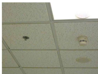
ภาพที่ 9-A อุปกรณ์ระบบป้องกันและเตือนอัคคีภัย
