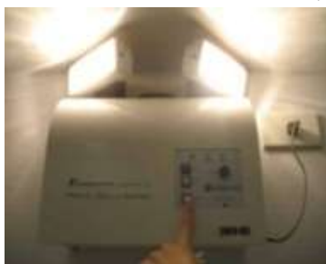
รูปที่ 27 การตรวจสอบสภาพความพร้อมใช้ของระบบไฟฉุกเฉินในโรงพยาบาล
