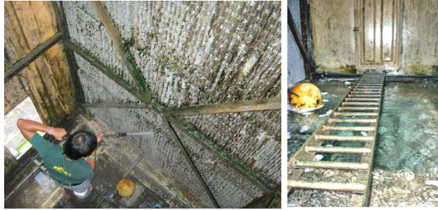
ภาพที่ 10-C การล้างทำความสะอาดถาดรับน้ำระบบระบายอากาศ
