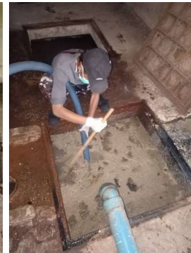
ภาพที่ 3-C สูบลบตะกอนส่วนเกินไปกำจัด ทุกวันที่ 10,20,30 ของเดือน
