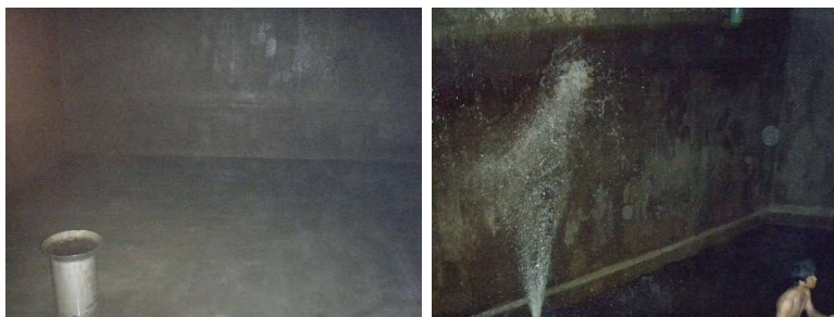
ภาพที่ 10-B การล้างทำความสะอาดท่อเก็บน้ำของโรงพยาบาล
