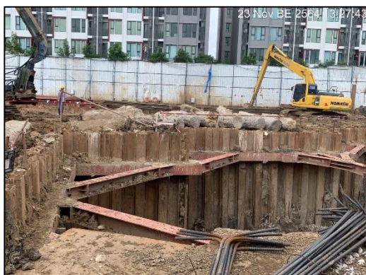
ภาพที่ 2 การทำ Sheet Pile ค้ำยันให้แข็งแรง
