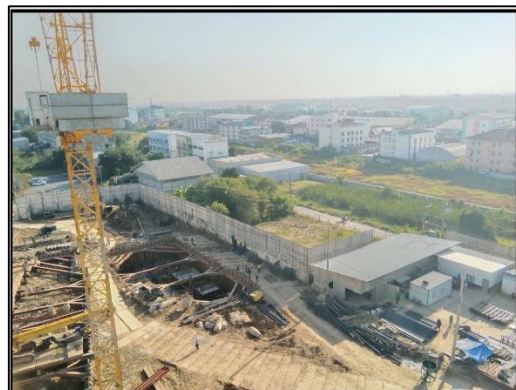
ภาพที่ 1 รั้ว Metal Sheet สูง 6 เมตร โดยรอบพื้นที่ก่อสร้าง
