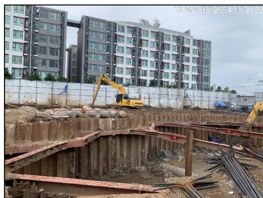
ภาพที่ 2 การทำ Sheet Pile ค้ำยันให้แข็งแรง
