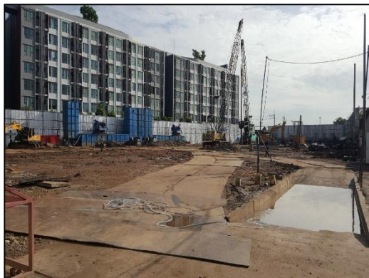
ภาพที่ 1 รั้ว Metal Sheet สูง 6 เมตร โดยรอบพื้นที่ก่อสร้าง
