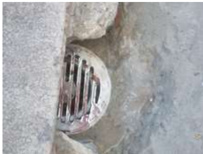
ภาพที่ 6-H สภาพที่ระบายน้ำรอบห้องพักขยะ ซึ่งน้ำที่เกิดขึ้นมีการระบายลงสู่ระบบบำบัดน้ำเสียของโรงพยาบาล
