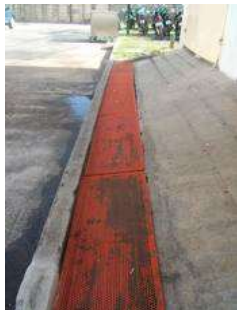
ภาพที่ 6-H สภาพที่ระบายน้ำรอบห้องพักขยะ ซึ่งน้ำที่เกิดขึ้นมีการระบายลงสู่ระบบบำบัดน้ำเสียของโรงพยาบาล
