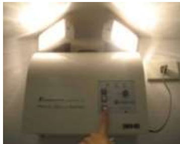
รูปที่ 22 การตรวจสอบสภาพความพร้อมใช้ของระบบไฟฉุกเฉินในโรงพยาบาล
