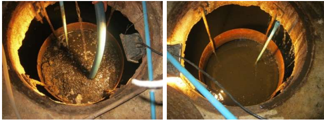
ภาพที่ 3-B บ่อสูบน้ำตะกอนกลับ
