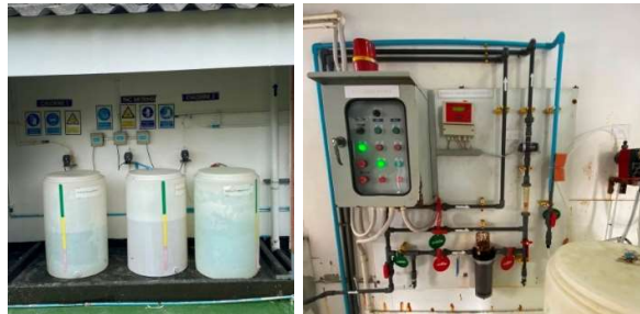
ภาพที่ 10-E การควบคุมค่าคลอรีนคงเหลือในถังเก็บน้ำประปา(น้ำใช้) และน้ำทิ้งของโรงพยาบาล
