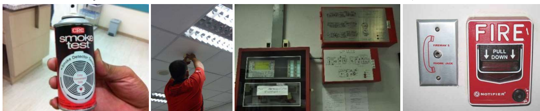
รูปที่ 23 การตรวจสอบสภาพความพร้อมใช้ของระบบสัญญาณแจ้งเหตุเพลิงไหม้
