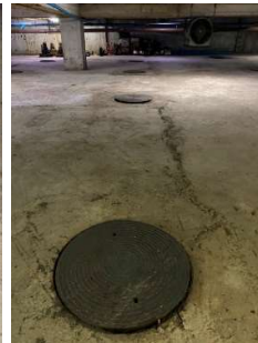
ภาพที่ 3-E การตรวจสอบฝาปิดบ่อน้ำเสียประจำเดือน
