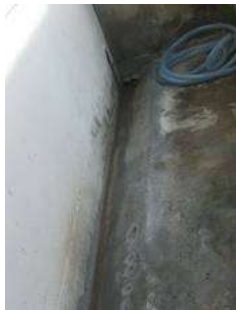
ภาพที่ 6-H สภาพที่ระบายน้ำรอบห้องพักขยะ ซึ่งน้ำที่เกิดขึ้นมีการระบายลงสู่ระบบบำบัดน้ำเสียของโรงพยาบาล
