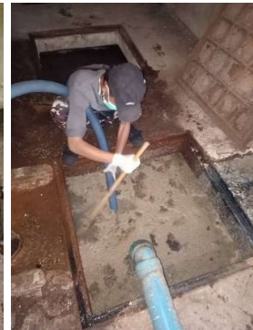
ภาพที่ 3-C สูบน้ำตะกอนส่วนเกินไปกำจัด ทุกวันที่ 10,20,30 ของเดือน
