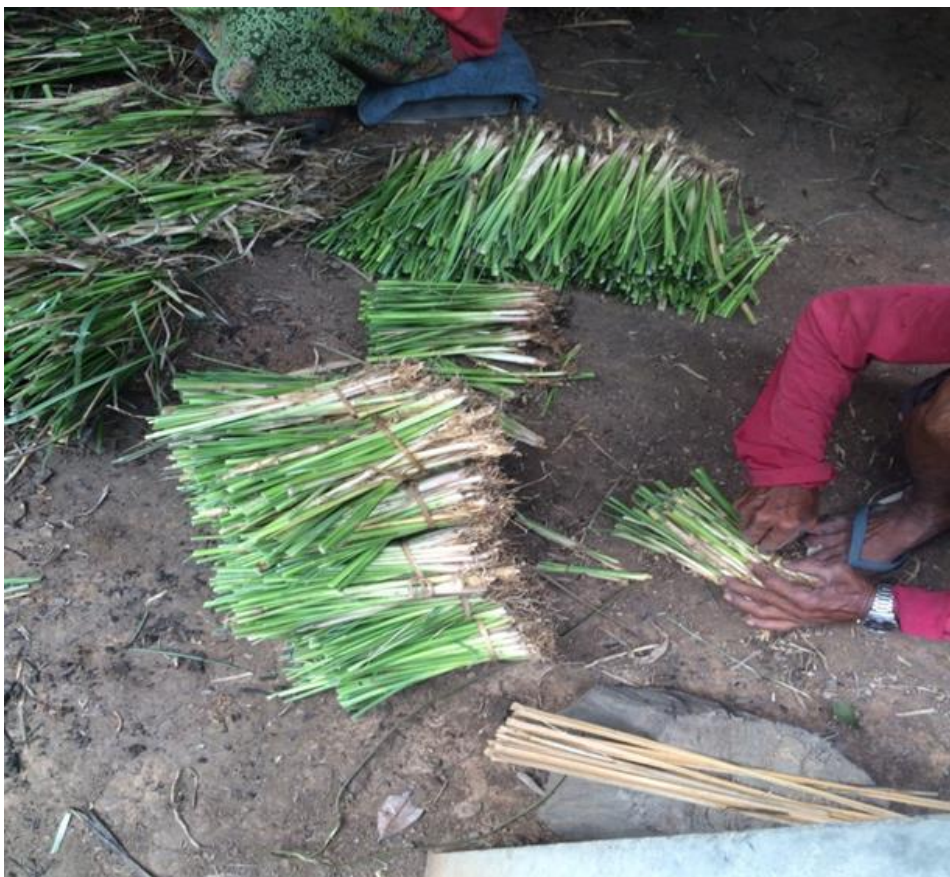
ภาพที่ แสดงการเตรียมพันธุ์ไม้หญ้าแฝก เพื่อปลูกแนวคันดินป้องกันดินสไลด์
