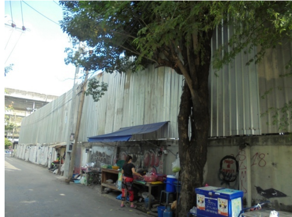
ภาพที่ 6-1 รั้วชั่วคราว Metal Sheet สูง 6 เมตร กันขอบเขตพื้นที่โครงการ
