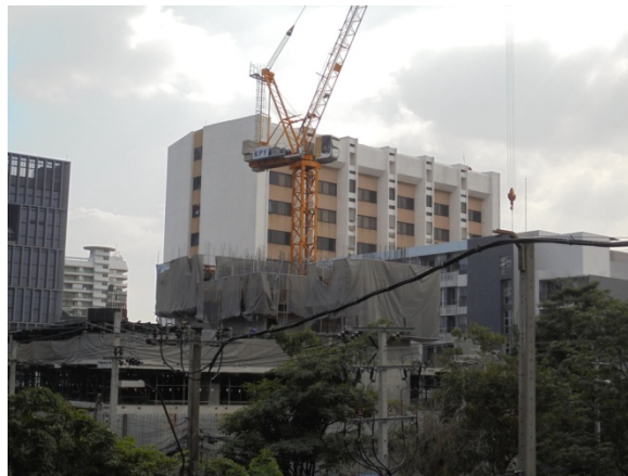
ภาพที่ 6-23 ปัจจุบันใช้ทาวเวอร์เครน แขนเครนอยู่ภายในโครงการ
