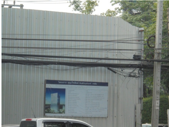
ภาพที่ 6-1 รั้วชั่วคราว Metal Sheet สูง 6 เมตร กันขอบเขตพื้นที่โครงการ
