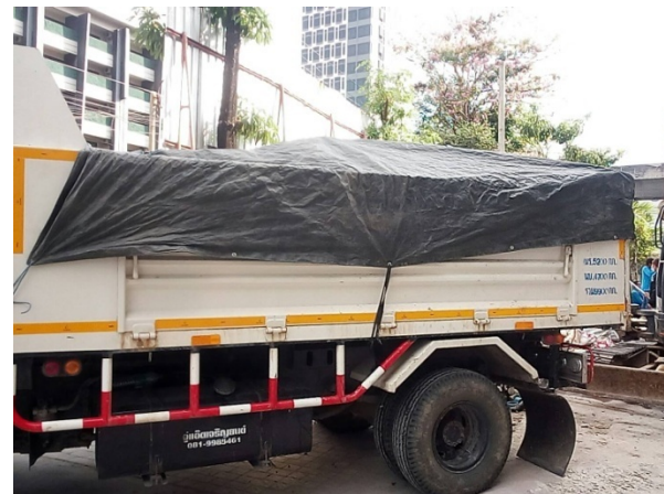
ภาพที่ 6-20 เก็บขนเศษวัสดุก่อสร้างออกนอกพื้นที่โครงการด้วยรถบรรทุก และปิดคลุมท้ายรถอย่างมิดชิดก่อนออกจากโครงการ
