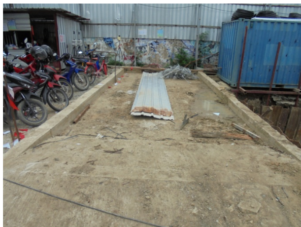
ภาพที่ 6-17 ป่อล้างล้อภายในโครงการ
