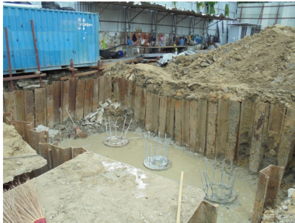
ภาพที่ 6-16 ระบบป้องกันดินพัง Sheet Pile ในการทำสาธารณูปโภคใต้ดิน
