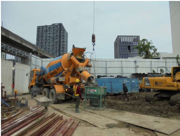
ภาพที่ 6-14 พื้นที่จอดรถบรรทุกไว้ในโครงการ และปูแผ่นเหล็กหนาเป็นทางวิ่งรถ และปิดคลุมอาคาร
