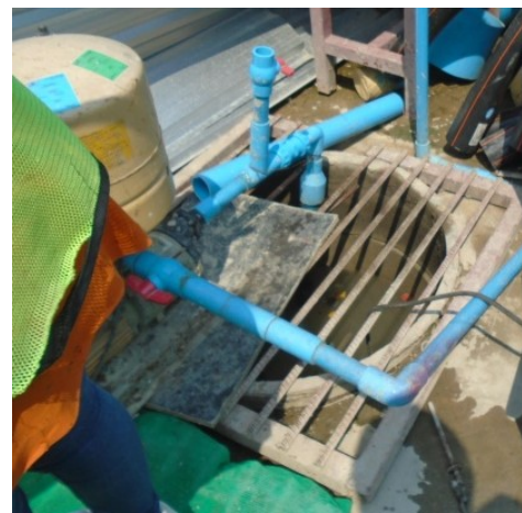
4-34 รางระบายน้ำรอบอาคาร และบ่อพักตะกอน
