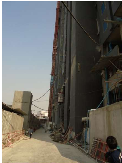
4-14 ถนนทางวิ่งรถคอนกรีตด้านหลังที่ติดกับโรงเรียนกนต์ธาราม ทำความสะอาดง่ายและป้องกันฝุ่นฟุ้งจากวิ่งรถ
