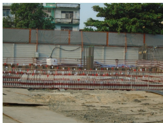
4-3 ระบบป้องกันดินพัง Sheet Pile และกันขอบเขตพื้นที่อันตราย
