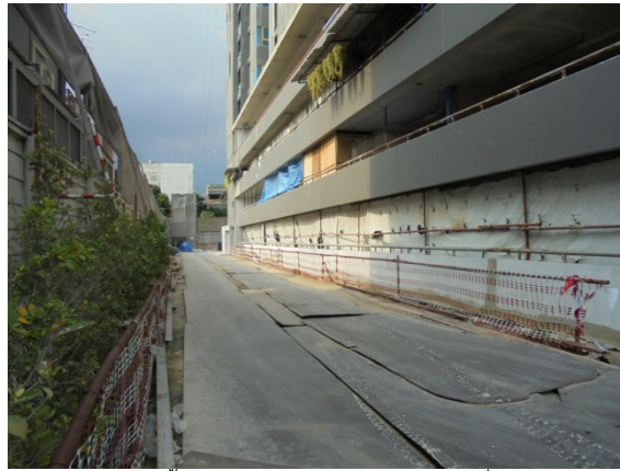
4-7 ปูพื้นด้วยแผ่นเหล็กหนาเป็นเส้นทางวิ่งรถ
