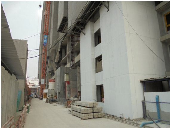
4-11 ติดตั้งลิฟต์ชั้นของ และตั้งโครงเหล็กซึ่ง Meshsheet ปิดคลุมอาคาร
