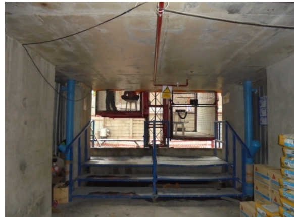
4-11 ติดตั้งลิฟต์ชั้นของ และตั้งโครงเหล็กซึ่ง Meshsheet ปิดคลุมอาคาร
