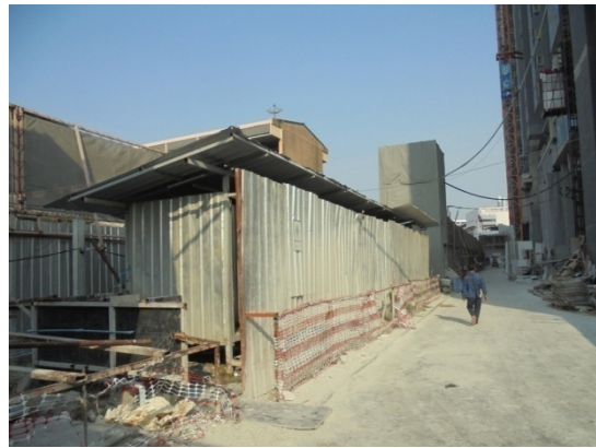
4-10 จัดทำรั้วโครงการ และทำหลังคาเหล็กปิดคลุมถนนด้านติดกับโรงเรียนกันตทาราราม ป้องกันเศษวัสดุร่วงหล่นปัจจุบันนำออกแล้ว
