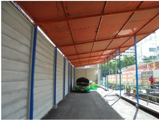
4-10 จัดทำรั้วโครงการ และทำหลังคาเหล็กปิดคลุมถนนด้านติดกับโรงเรียนกันตทาราราม ป้องกันเศษวัสดุร่วงหล่นปัจจุบันนำออกแล้ว
