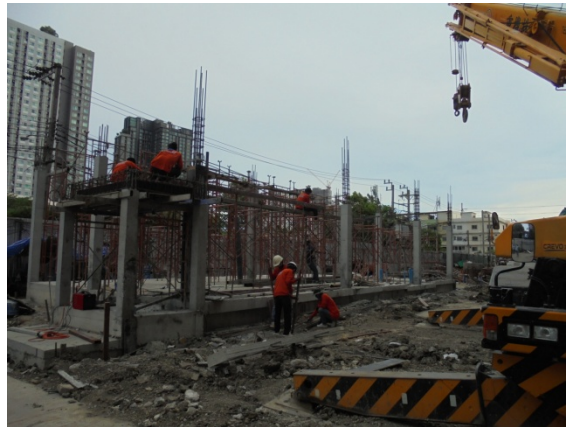
4-4 ติดตั้งนั่งร้านก่อสร้างโครงสร้างอาคาร
