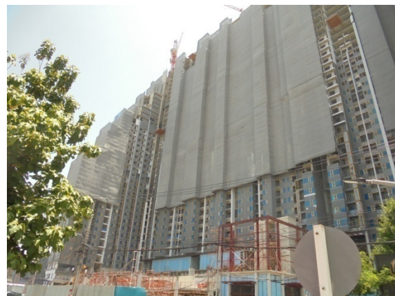
4-9 ปิดคลุมอาคารด้วย Mesh Sheet
