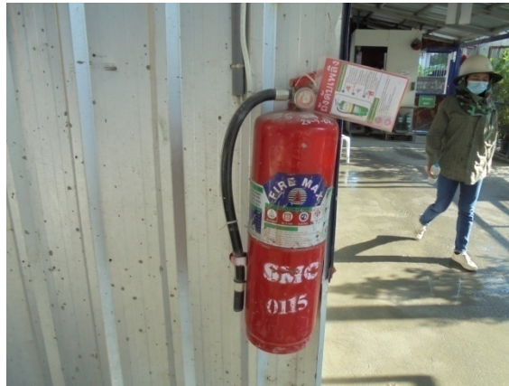
4-33 ติดตั้งถังเคมีดับเพลิงพร้อมวิธีใช้
