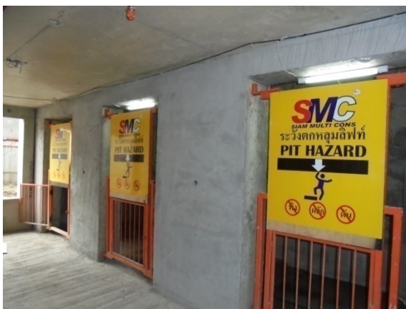
4-15 ติดป้ายเตือนและแผ่นกันบริเวณหลุมลิฟต์
