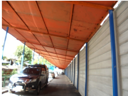
4-10 จัดทำรั้วโครงการ และทำหลังคาเหล็กปิดคลุมถนนด้านติดกับโรงเรียนกันตทาราราม ป้องกันเศษวัสดุร่วงหล่น
