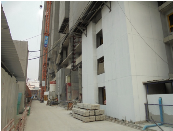
4-11 ติดตั้งลิฟต์ขนของ และตั้งโครงเหล็กซึ่ง Meshsheet ปิดคลุมอาคาร
