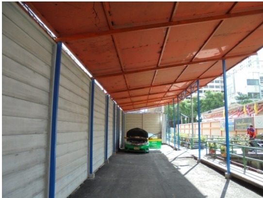
4-10 จัดทำรั้วโครงการ และทำหลังคาเหล็กปิดคลุมถนนด้านติดกับโรงเรียนกันตทาราราม ป้องกันเศษวัสดุร่วงหล่น
