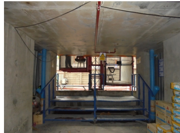
4-11 ติดตั้งลิฟต์ขนของ และตั้งโครงเหล็กซึ่ง Meshsheet ปิดคลุมอาคาร
