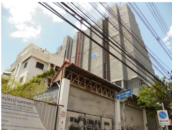
4-9 ปิดคลุมอาคารด้วย Mesh Sheet
