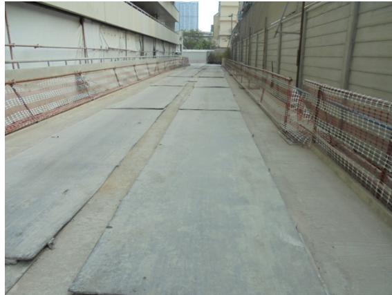
4-7 ปูพื้นด้วยแผ่นเหล็กหนาเป็นเส้นทางวิ่งรถ
