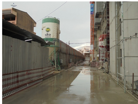
4-14 ถนนทางวิ่งรถคอนกรีตด้านหลังที่ติดกับโรงเรียนกันตทาราราม ทำความสะอาดง่ายและป้องกันฝุ่นฟุ้งจากวิ่งรถ
