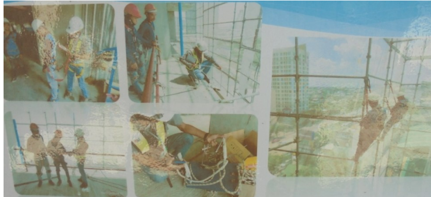
4-25 ตรวจสอบอุปกรณ์ป้องกันภัยส่วนบุคคลในการขึ้นที่สูง
