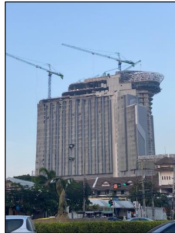
ภาพที่ 16 ติดตั้งผ้าใบ Mesh Sheet รอบตัวอาคาร
