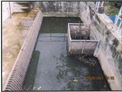
บ่อฟักก่อนเข้าระบบบำบัดน้ำเสียส่วนกลาง
