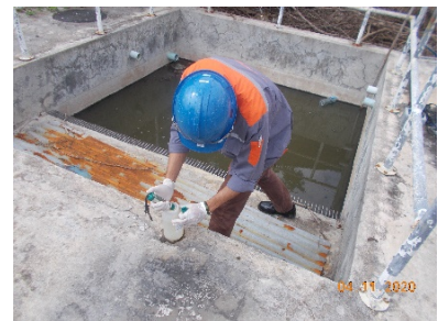
บ่อกักน้ำเสียก่อนไหลเข้าบ่อสูบล้างของระบบบำบัดน้ำเสียรวม
