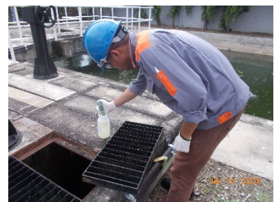
บ่อดตรวจคุณภาพ ซึ่งเป็นบ่อกักสุดท้ายก่อนระบายน้ำทิ้งลงสู่ระบายน้ำของโครงการอาคารเช่าเดิม
