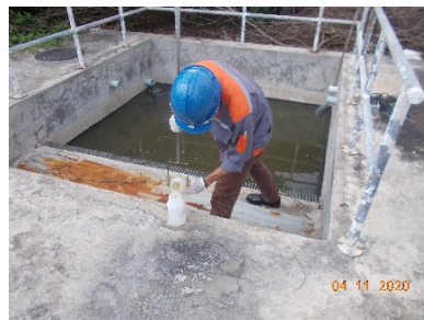
บ่อกักน้ำเสียก่อนไหลเข้าบ่อสูบล้างของระบบบำบัดน้ำเสียรวม
