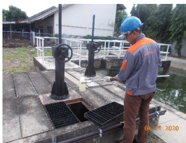
บ่อดตรวจคุณภาพ ซึ่งเป็นบ่อกักสุดท้ายก่อนระบายน้ำทิ้งลงสู่ระบายน้ำของโครงการอาคารเช่าเดิม
