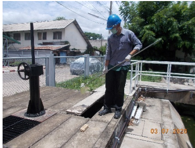
บ่อดตรวจคุณภาพ ซึ่งเป็นบ่อกักสุดท้ายก่อนระบายน้ำทิ้งลงสู่ระบายน้ำของโครงการอาคารเช่าเดิม
