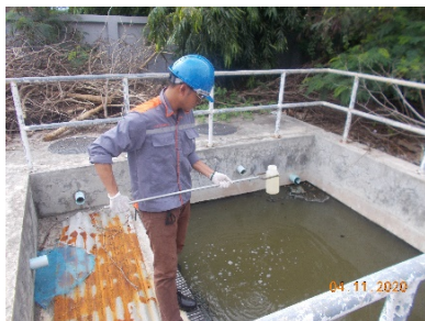
บ่อกักน้ำเสียก่อนไหลเข้าบ่อสูบล้างของระบบบำบัดน้ำเสียรวม
