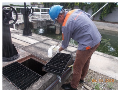
บ่อดตรวจคุณภาพ ซึ่งเป็นบ่อกักสุดท้ายก่อนระบายน้ำทิ้งลงสู่ระบายน้ำของโครงการอาคารเช่าเดิม
