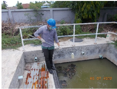
บ่อกักน้ำเสียก่อนไหลเข้าบ่อสูบล้างของระบบบำบัดน้ำเสียรวม
