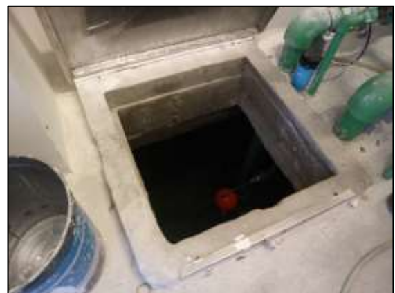
รูปที่ 3-25 ถังสำรองน้ำใช้ชั้นใต้ดิน
