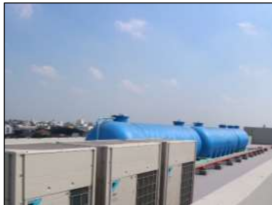
รูปที่ 3-26 ถังสำรองน้ำใช้ชั้นคาเฟ่
