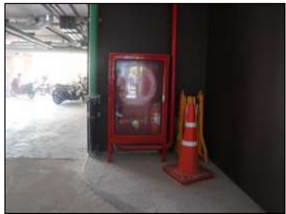
รูปที่ 3-30 ตู้เก็บอุปกรณ์ดับเพลิงและป้ายแนะนำการใช้งาน
