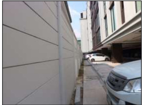
รูปที่ 3-5 กำแพงคอนกรีตเสริมเหล็ก
