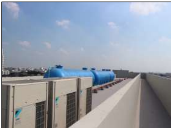
รูปที่ 3-26 ถังสำรองน้ำใช้ชั้นคาเฟ่
