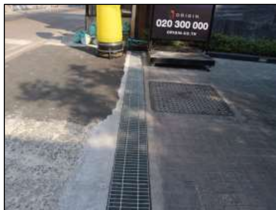
รูปที่ 3-28 บ่อพักน้ำเสียก่อนปล่อยสู่สาธารณะด้านหน้าโครงการ
