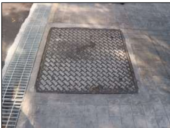
รูปที่ 3-28 บ่อพักน้ำเสียก่อนปล่อยสู่สาธารณะด้านหน้าโครงการ
