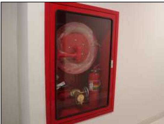
รูปที่ 3-30 ตู้เก็บอุปกรณ์ดับเพลิงและป้ายแนะนำการใช้งาน
