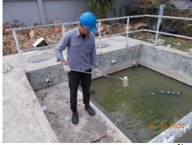
บ่อกักน้ำเสียก่อนไหลเข้าบ่อสูบของระบบบำบัดน้ำเสียรวม
