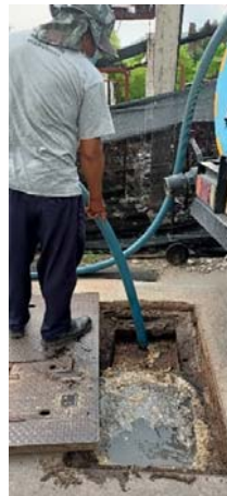
รูปที่ 1.6 (3) การสูบล้างตะกอนออกจากระบบบำบัดไปกำจัด
