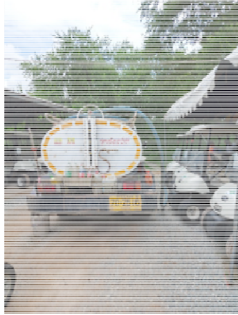
รูปที่ 1.6 (3) การสูบล้างตะกอนออกจากระบบบำบัดไปกำจัด
