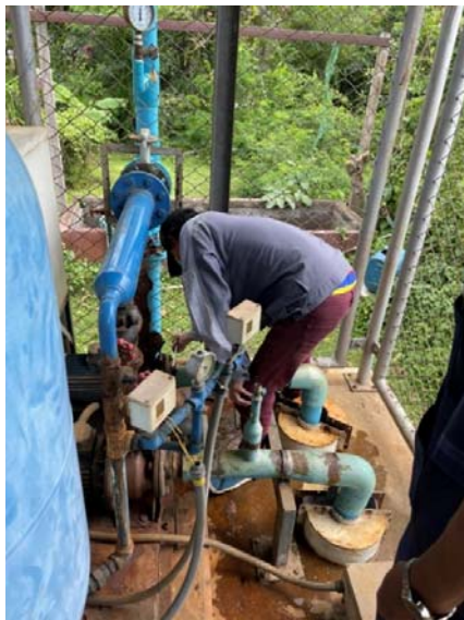
รูปที่ 2.1 ตรวจสอบรอยแตก/ชำรุดของระบบจ่ายน้ำ และระบบเส้นท่อประปาให้อยู่ในสภาพดีอยู่เสมอ
