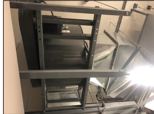
ภาพที่ 30 ติดตั้งเครื่องปรับอากาศภายใน ห้องหม้อแปลงไฟฟ้า
