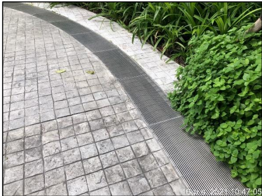
ภาพที่ 39 รางระบายน้ำ และตะแกรงดักขยะ
