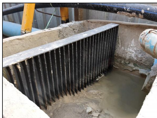
ภาพที่ 35 ตะแกรงดักขยะ
