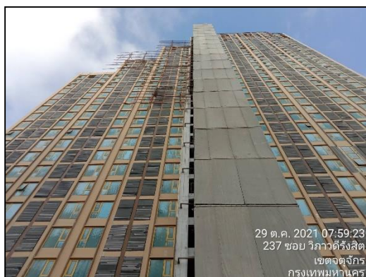
ภาพที่ 7 ผ้าใบกันฝุ่น (Mesh sheet)
