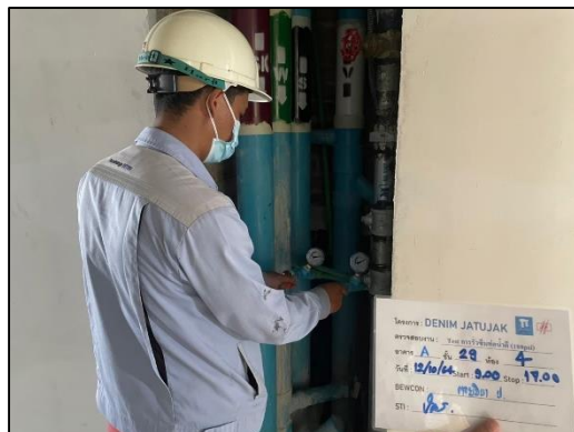
ภาพที่ 39 ตรวจสอบการรั่วซึมของระบบน้ำประปา
