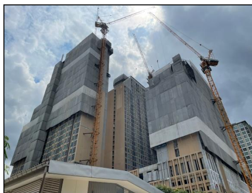
ภาพที่ 7 ผ้าใบกันฝุ่น (Mesh sheet)
