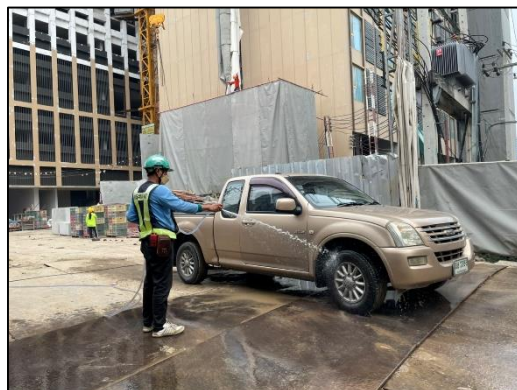
ภาพที่ 11 ล้างล้อรถก่อนออกนอกโครงการ
