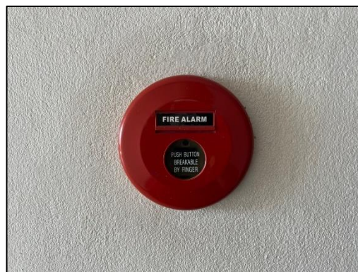
ภาพที่ 28 Fire Alarm Manual Station
