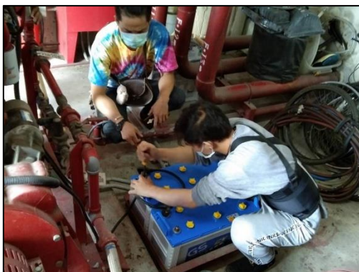
ภาพที่ 86-87 ตรวจสอบสภาพแบตเตอรี่ในห้อง Fire Pump
