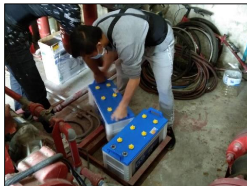
ภาพที่ 86-87 ตรวจสอบสภาพแบตเตอรี่ในห้อง Fire Pump
