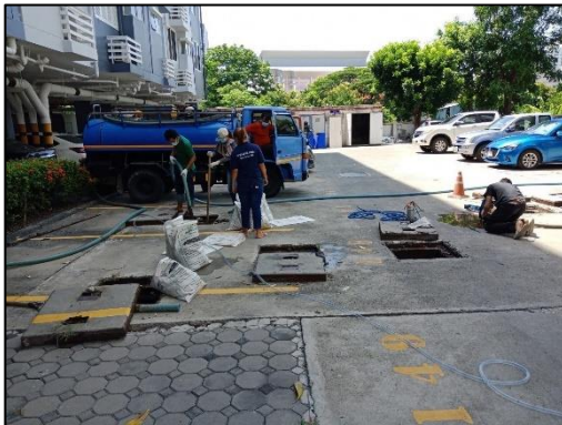
ภาพที่ 8-11 เจ้าหน้าที่สูบลากตะกอน และ สูบอัดถังไขมัน
