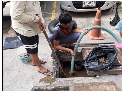
ภาพที่ 8-11 เจ้าหน้าที่สูบลากตะกอน และ สูบอัดถังไขมัน
